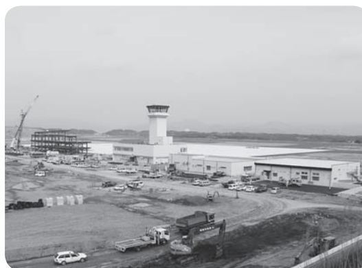
建設が進む空港施設
