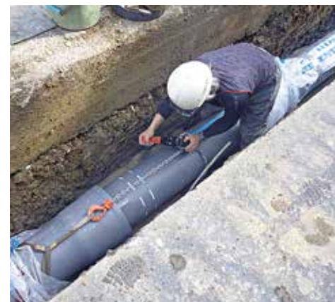
市内での配水管工事の様子
