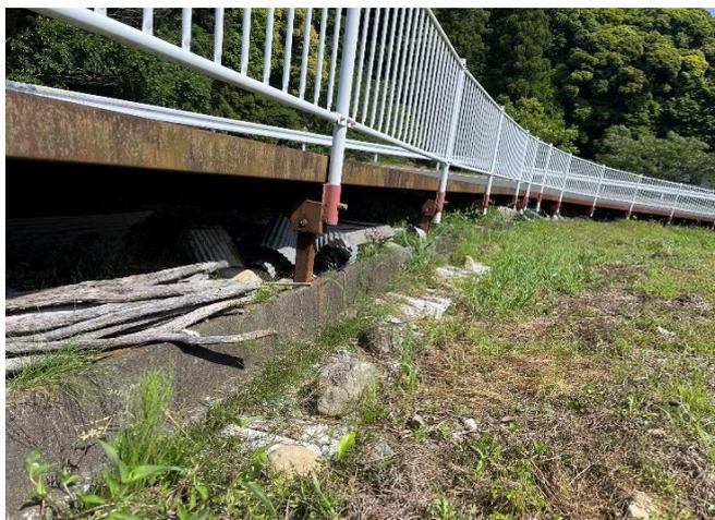
拡幅された歩道の支持方法（水路側に設置してある）
