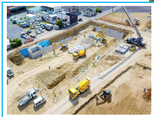
工事写真（高台開発事業）
