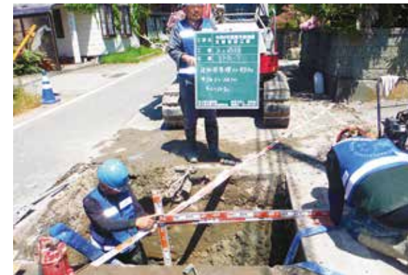
被災地で水道管の漏水修繕を行う管工事協同組員
