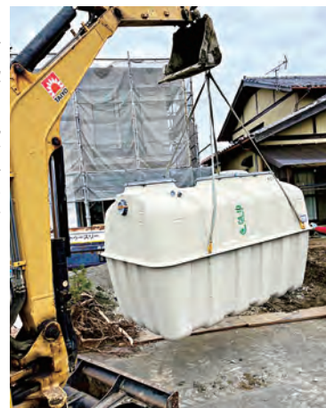
浄化槽の設置工事
