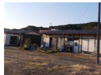
主要建物の外観
