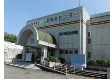
主要建物の外観
