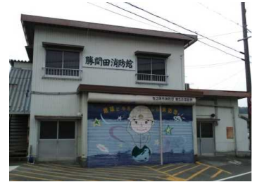
主要建物の外観
