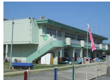
主要建物の外観
