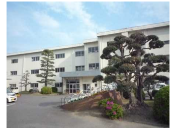
主要建物の外観
