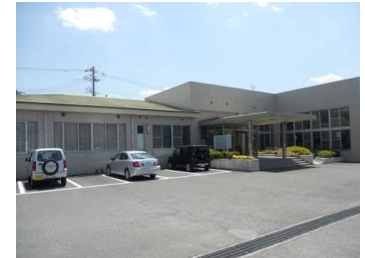
主要建物の外観
