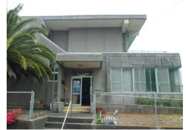
主要建物の外観
