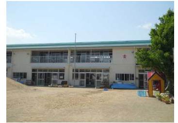
主要建物の外観
