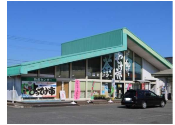
主要建物の外観
