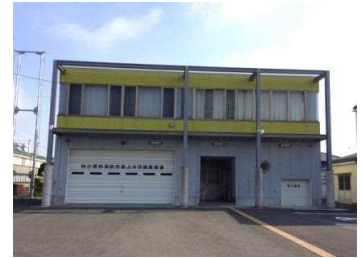
主要建物の外観
