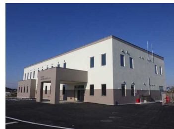
主要建物の外観
