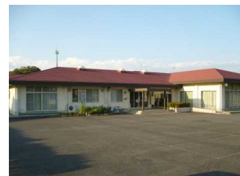
主要建物の外観
