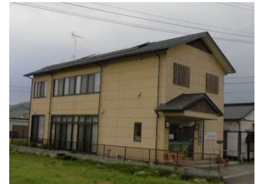
主要建物の外観
