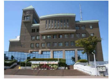
主要建物の外観
