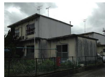
主要建物の外観
