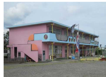
主要建物の外観
