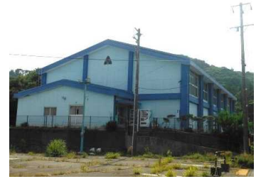
主要建物の外観
