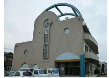
主要建物の外観
