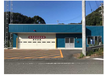
主要建物の外観
