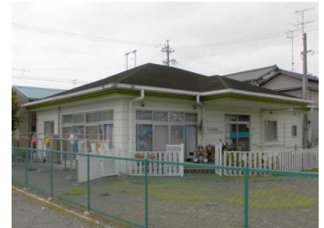
主要建物の外観
