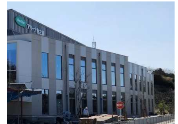
主要建物の外観
