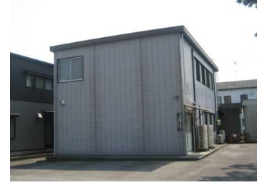
主要建物の外観
