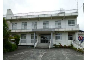
主要建物の外観
