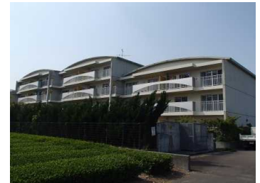
主要建物の外観
