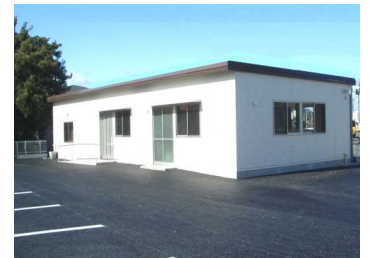
主要建物の外観
