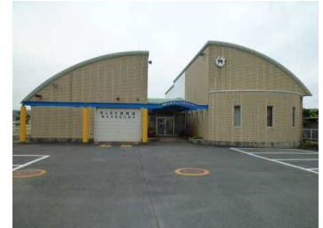
主要建物の外観
