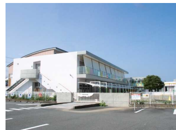
主要建物の外観
