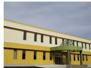
主要建物の外観
