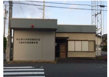
主要建物の外観
