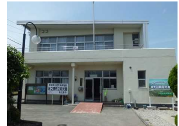
主要建物の外観
