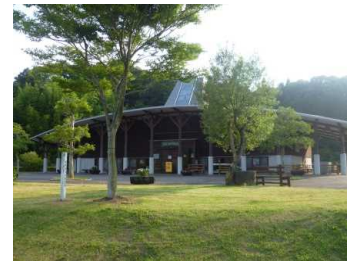
主要建物の外観
