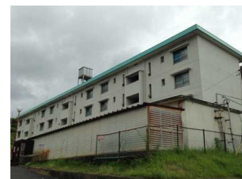
主要建物の外観
