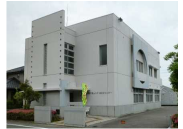
主要建物の外観
