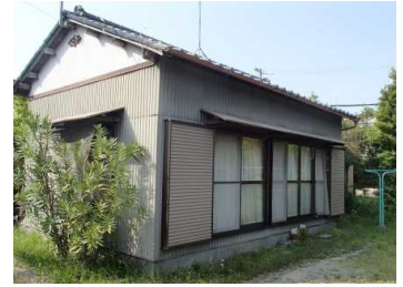
主要建物の外観
