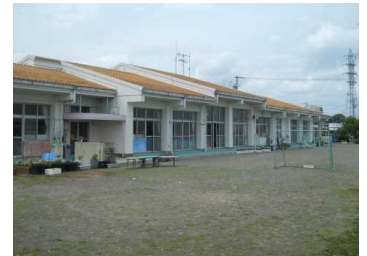
主要建物の外観
