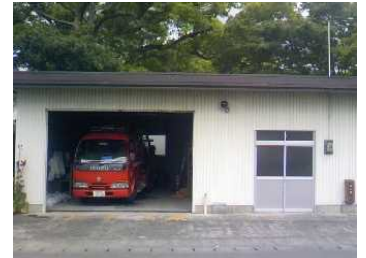
主要建物の外観
