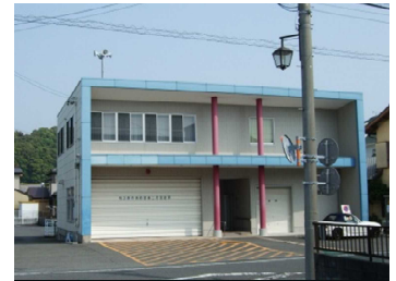
主要建物の外観
