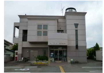
主要建物の外観
