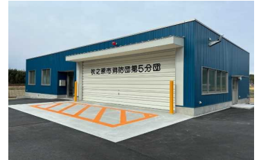
主要建物の外観
