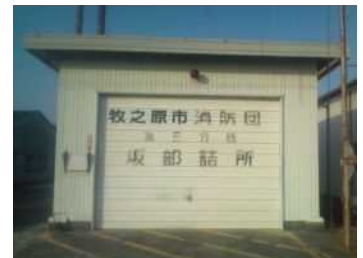
主要建物の外観
