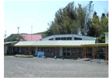
主要建物の外観
