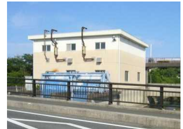
主要建物の外観
