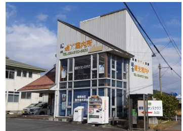
主要建物の外観
