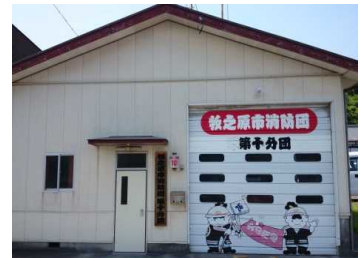
主要建物の外観
