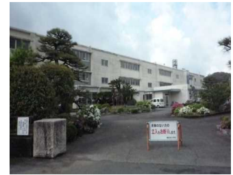
主要建物の外観
