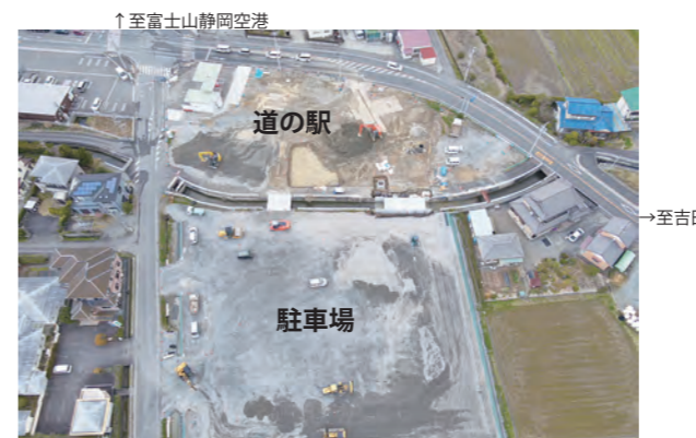
造成工事中の「道の駅」(3月27日撮影)
