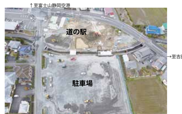
造成工事中の「道の駅」(3月27日撮影)
