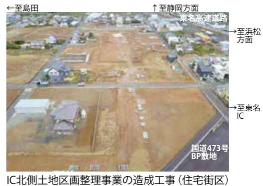
IC北側土地区画整理事業の造成工事（住宅街区）
