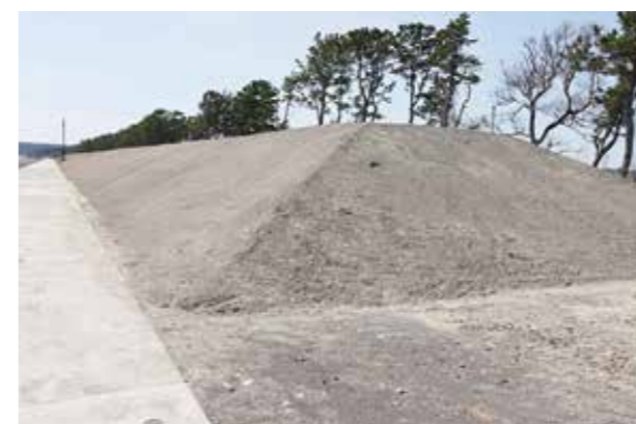
令和5年度に整備した細江地区の海岸防潮堤(レベル2 想定)
