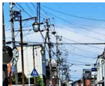
日中も点灯している市内の街路灯
