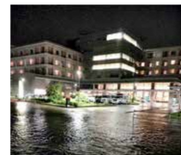
令和元年台風19号で浸水した 榎原総合病院駐車場
