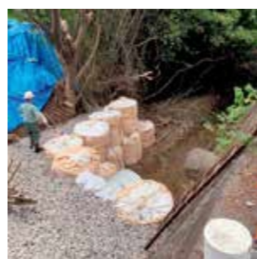
東沢川地滑り災害復旧の様子
