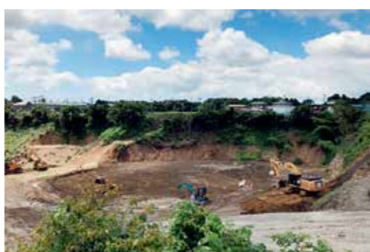
静谷地区の盛土現場
