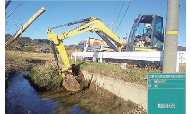
準用河川白羽川の浚渫(堀之内)
