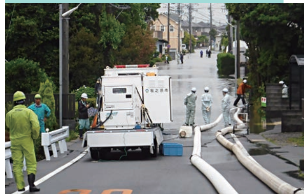
排水ポンプ車による排水作業
