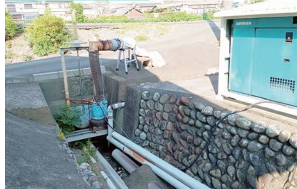
既存ポンプ隣に1基増設予定(東福田)
