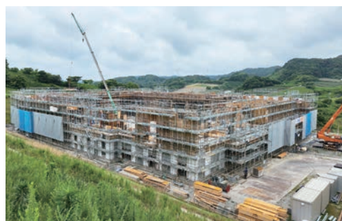
建設工事中の市多目的体育館
