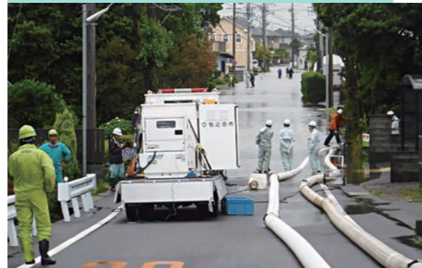
排水ポンプ車による排水作業
