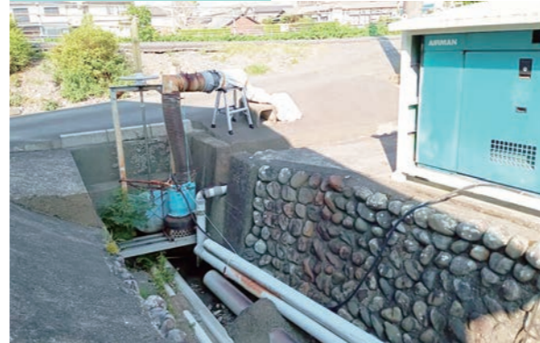
既存ポンプ隣に1基増設予定(東福田)
