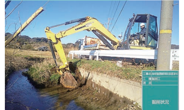
準用河川白羽川の浚渫(堀之内)
