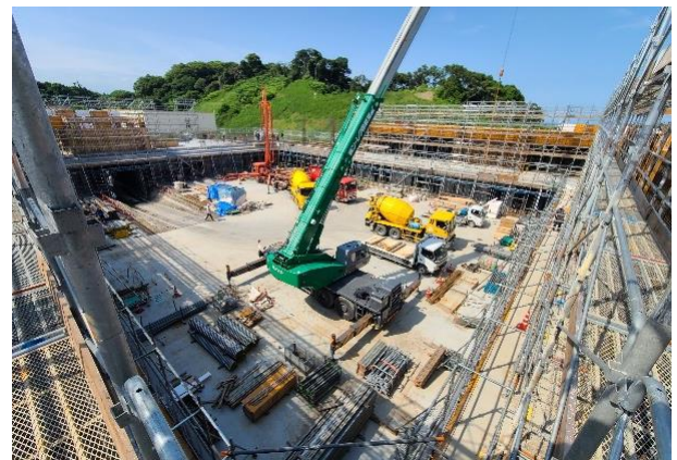
▲2階躯体工事の状況
