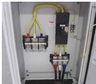
停電時に電源車に接続するための電源接続盤
