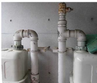
都市ガスエリアでも災害時にLPガスを使用できるように変換機の接続口を整備
