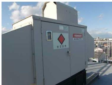
浸水対策として屋上に設置されている自家発電設備
