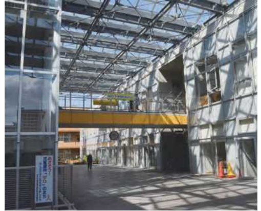
普通教室棟と生涯学習棟をつなぐ2階テラスとブリッジ
