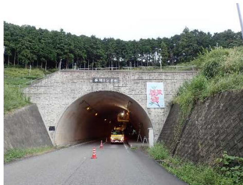
写真2 薬師トンネル点検状況
