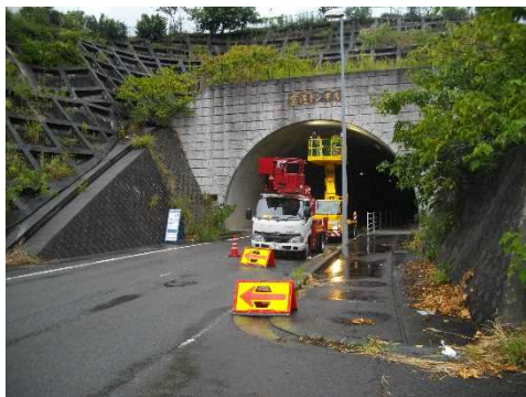
写真1 空港トンネル点検状況
