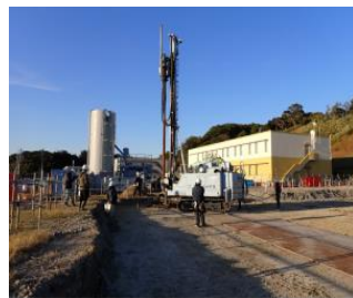
柱状改良施工中
