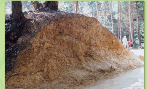
8 二の曲輪土塁 曲輪を平坦に造成した際の廃土が硬く積み重ねられていました。土塁を挟み、二の曲輪よりも三の曲輪が2m程低い、段造りの地形です。
