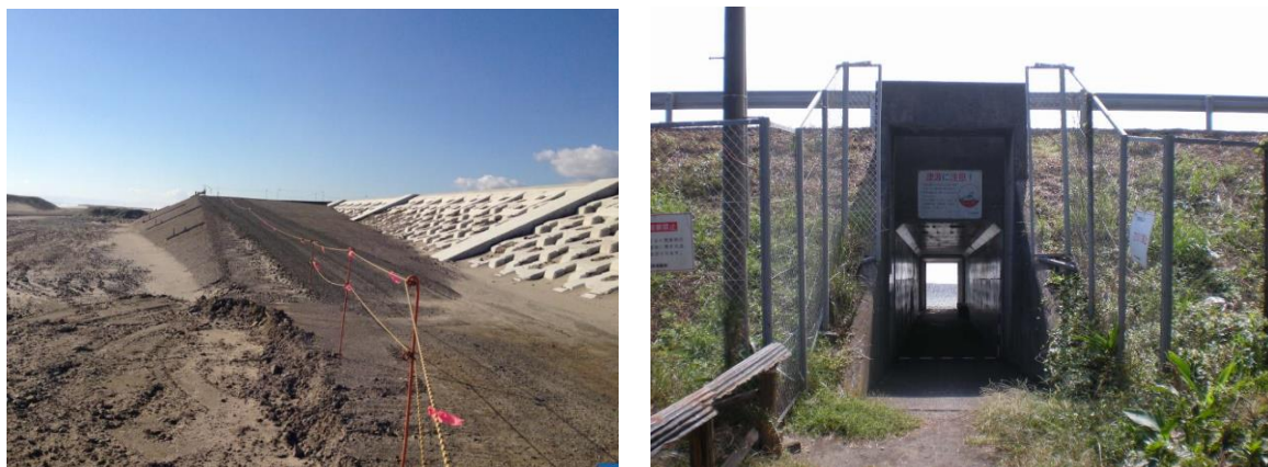
図 3-9 乗り越え坂路の例(左写真)、ボックスカルバートの例(右写真)
