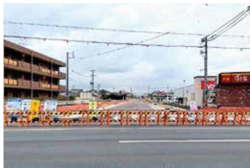
静波地区道路新設工事
