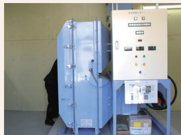
陽圧化「空気清浄」装置
