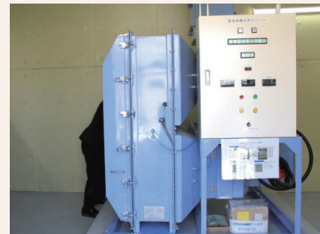
陽圧化「空気清浄」装置
