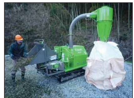
▲樹木粉砕機での作業の様子
