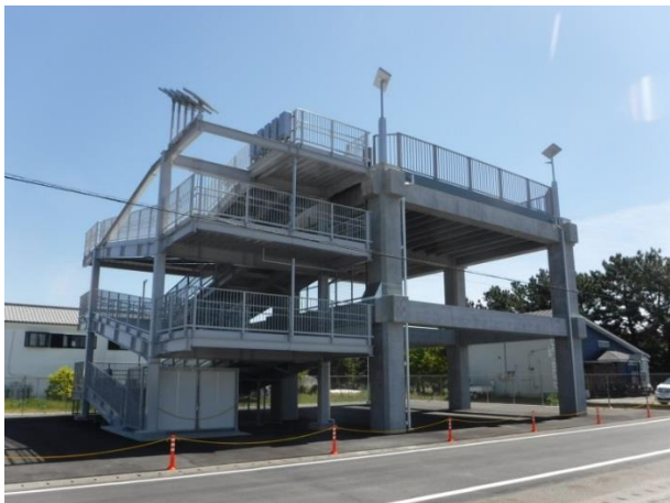
津波避難タワーEブロック（静波区）
