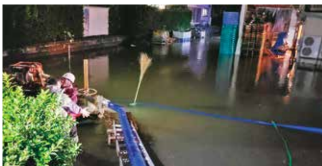
令和元年の台風19号による浸水被害 ホースを接続しての排水作業
