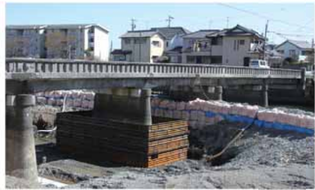
勝間田川湊橋の補修工事
