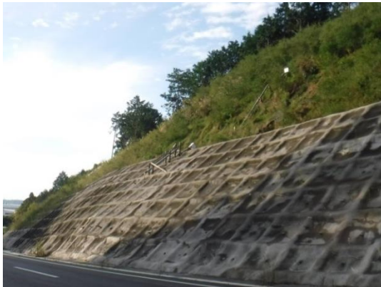
□法面の法枠孕みの状況 (10/18 撮影)
