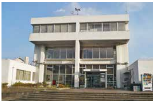
解体工事が行われる相良公民館
