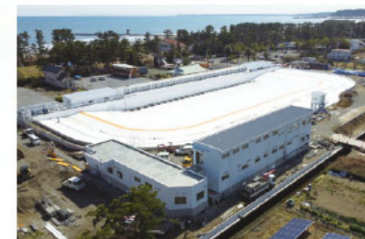
建設中のウェブプール「静波サーフスタジアム」
