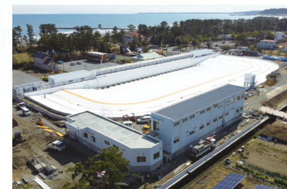
建設中のウエーブプール「静波サーフスタジアム」
