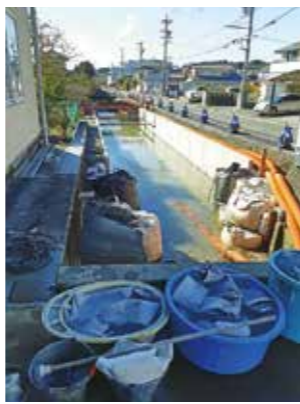
沢垂川の改修工事現場
