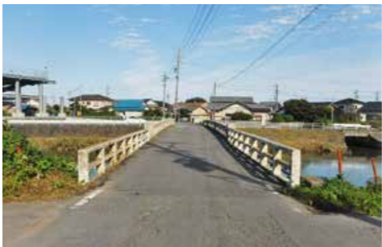
架け替えが計画されている後川橋 (うしろがわばし)
