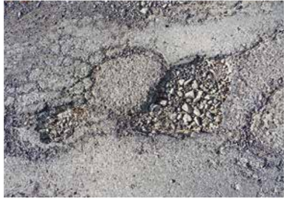
市道における陥没箇所
