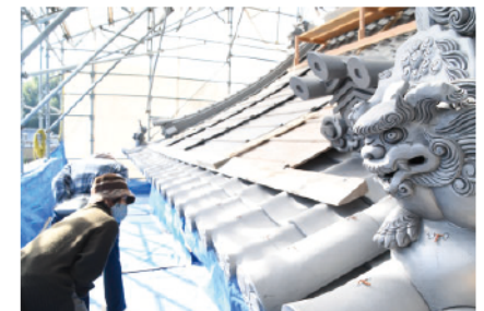
きれいに仕上げられた山門屋根を見学する地域住民
