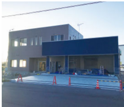
建設中の地頭方消防館
