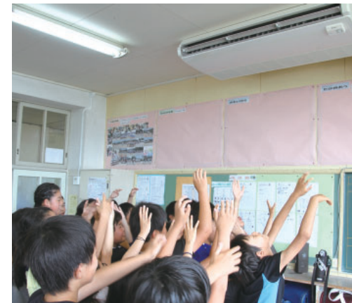
教室に空調設備を設置
