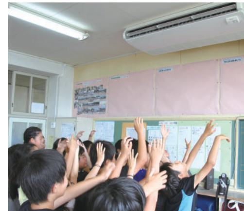
教室に空調設備を設置
