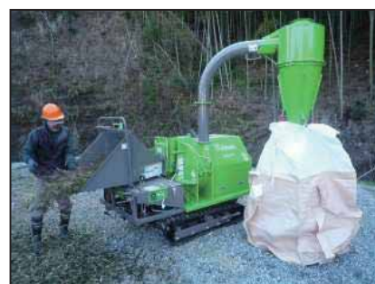
▲樹木粉碎機での作業の様子
