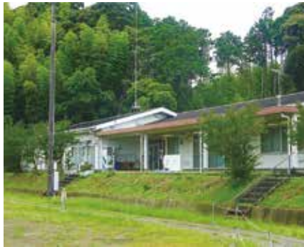
エアコンの改修を行う萩間公民館
