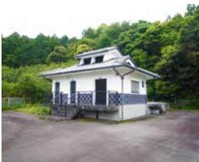
修繕を行った「笠名処理施設」
