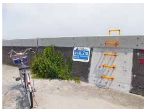
かさ上げされた片浜地区の防潮堤
