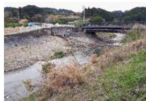
本流（勝間田川）と支流の合流点に支流より流れ込む土砂
