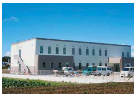
工事中の放射線防護施設 (令和2年3月完成：トーク地頭方西隣)
