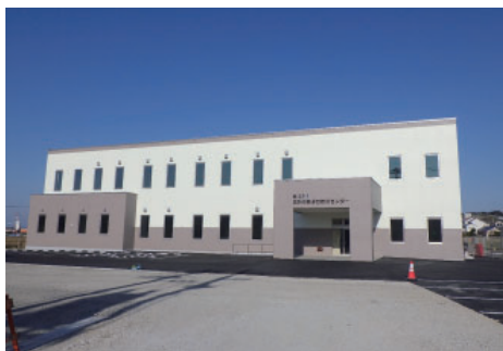
地頭方地区放射線防護施設
