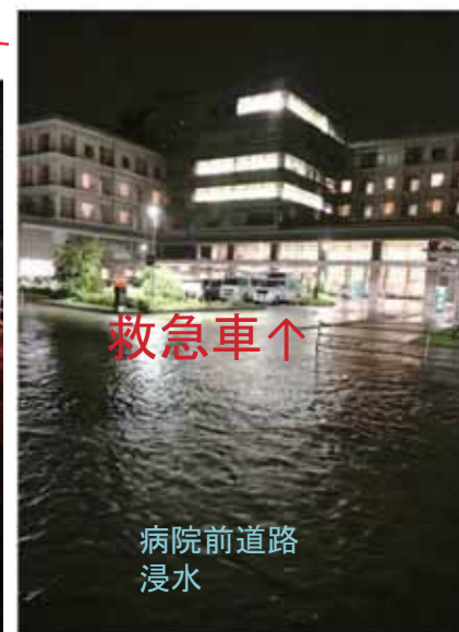
救急車↑ 病院前道路 浸水 ■榛原総合病院 浸水状況 (10/12 18:00撮影)
