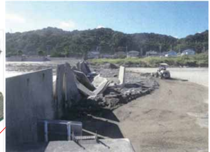
■ 坂井平田港 防波護岸 L型擁壁破損(10/13撮影)
