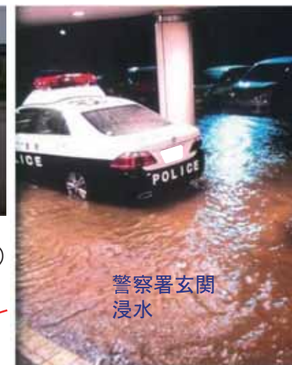
警察署玄関 浸水 ■牧之原警察署 浸水状況 (10/12 18:00撮影)
