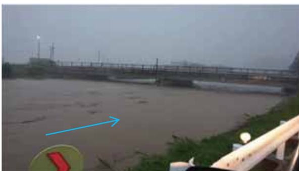
■勝間田川 深谷橋 (10/12 17:20撮影)
