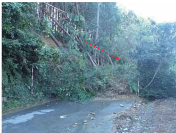
■市道 西萩間本線 土砂災害 通行止め (10/13撮影)
