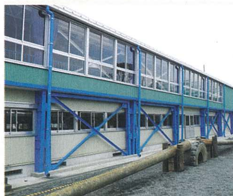
耐震化が完了した相良小学校体育館
