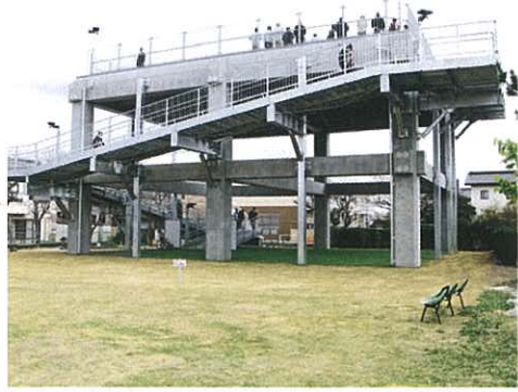
市内で第1号の津波避難タワーが完成
