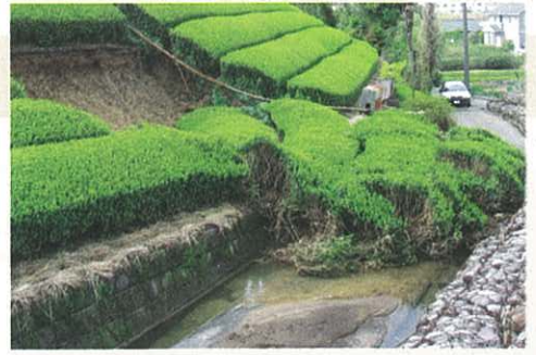
4月6日の豪雨による被害
