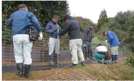
ワイヤーメッシュ柵を設置している様子
