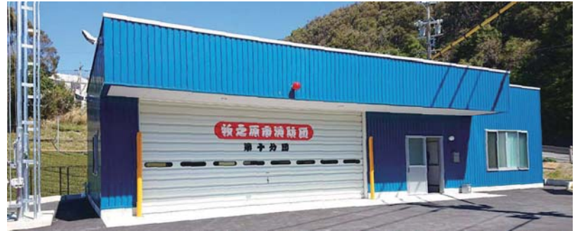
国道473号バイパス沿線IC付近に建設された「第10分団地頭方北詰所」
