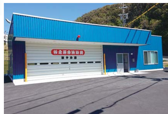
消防団の詰所を建設
