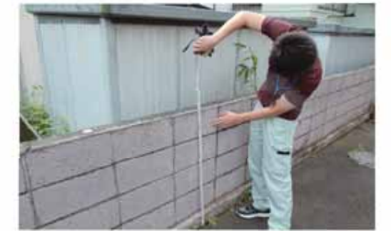
危険なブロック塀は改修・撤去を
