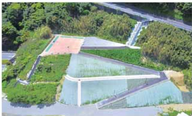
逸渡区に完成した避難地・避難路
