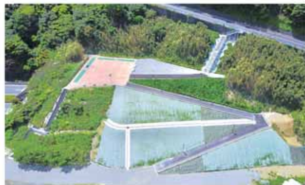
逸渡区に完成した避難地・避難路
