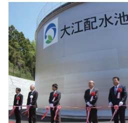
大江配水池完成
