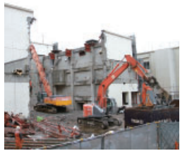
榛原文化センターホール棟 解体工事開始
